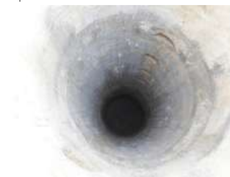
le puits à sec le 20 déc. 2013
