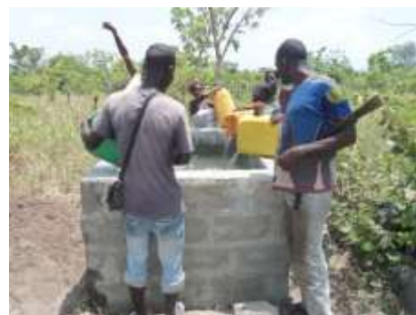
remplissage manuel du réservoir 12 mars 2014
