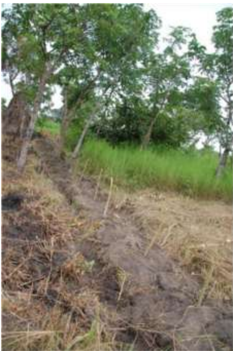
plantation de la clôture végétale
