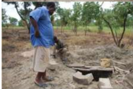
Creusement du puits en juillet 2013
