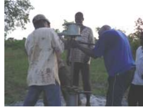
l'installation de la pompe manuelle sur le forage 19 jan. 2014
