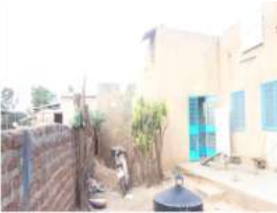
• Façade latérale gauche du local
