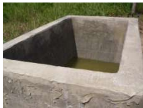
le réservoir 12 mai 2014
